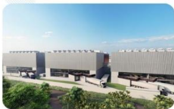
Data Center THAI DC1 20 MW
