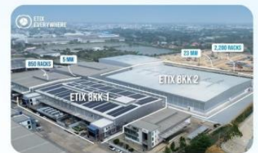
Data Center ETIX
